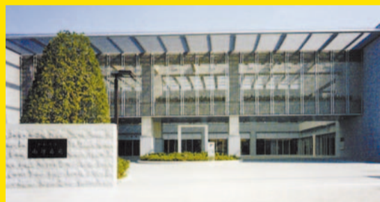
かわさき南部斎苑 川崎市川崎区夜光3-2-7
